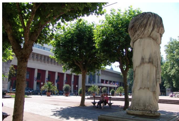
© OT Aix les Bains / François FOUGER Thermes Pétriaux depuis la place Mollard à Aix les Bains
